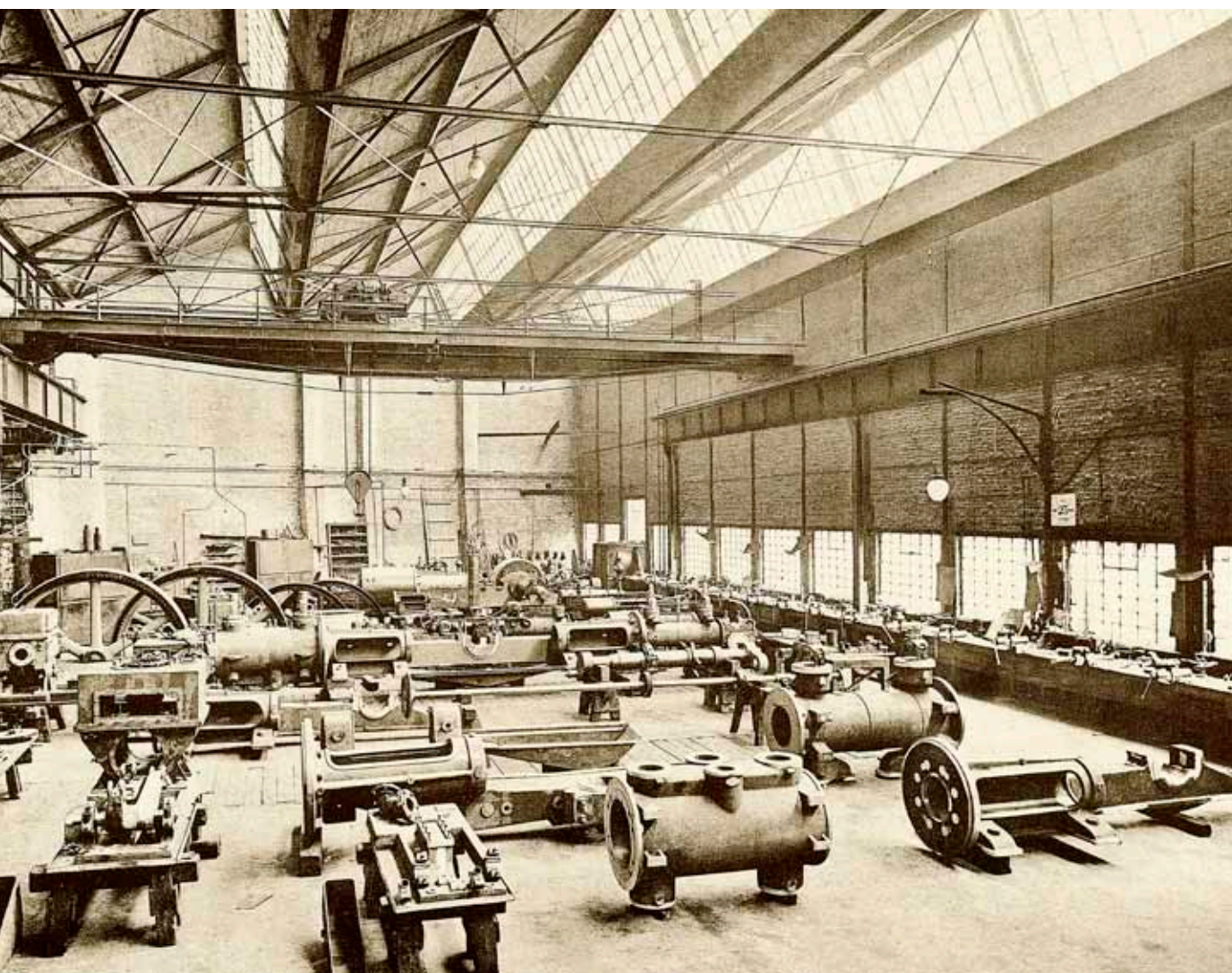
Montagehalle für Dampfmaschinen
