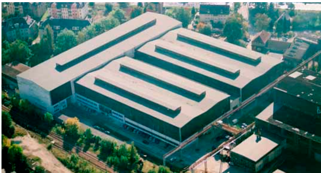
Luftbild des Firmengeländes
