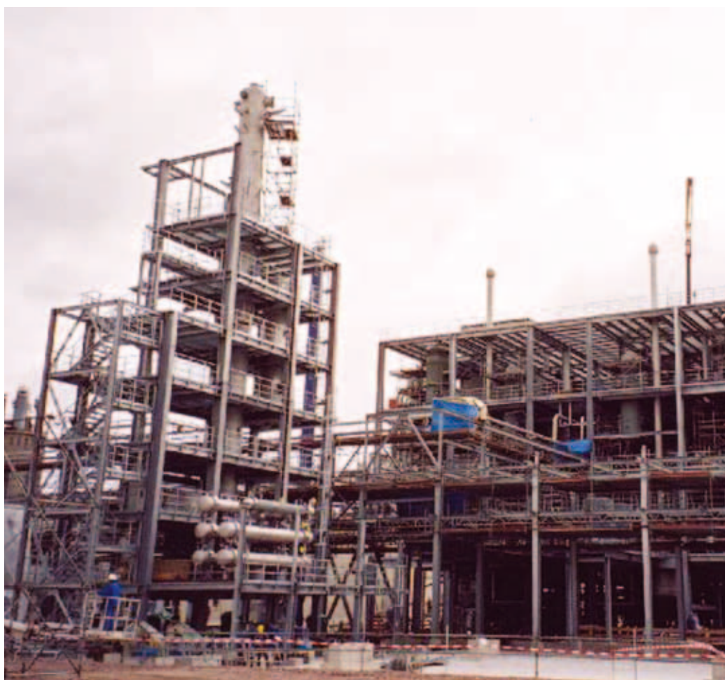
Die Melaminanlage in Piesteritz während der Montage
