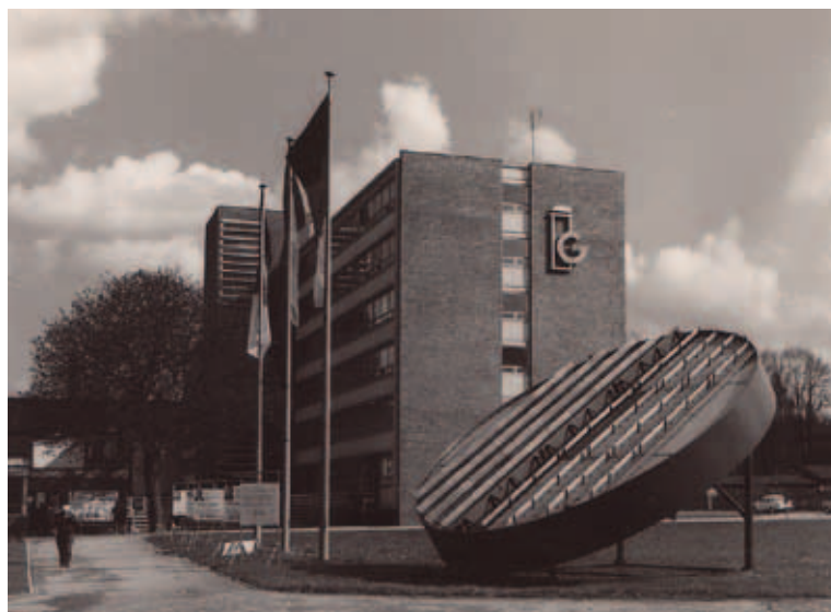
Verwaltungsgebäude des VEB Germania - der Anlagenbau saß in der 5. und 6. Etage - im Vordergrund der 1967 patentierte Perform-Kontaktboden
