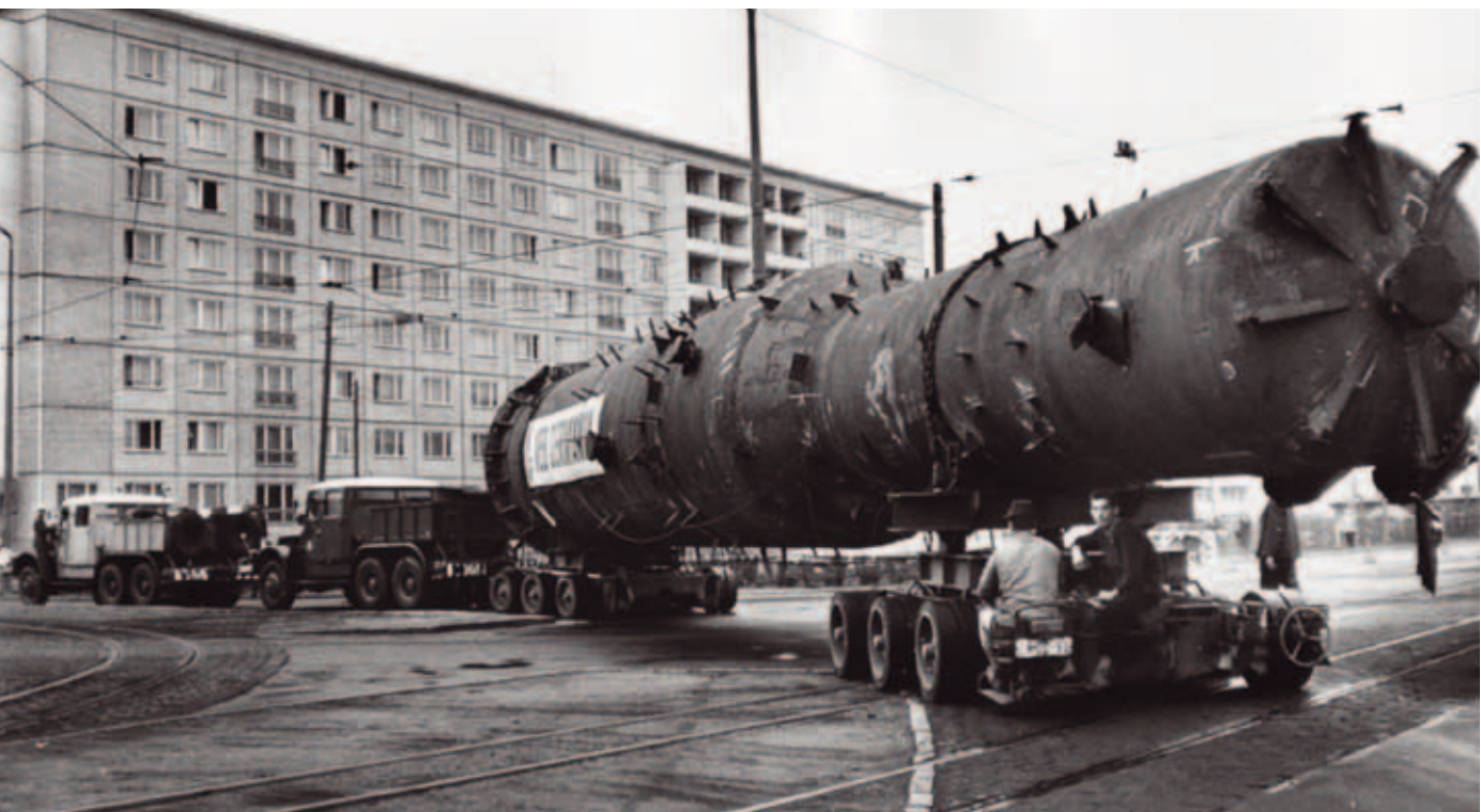
Öldruckvergasung Leuna I: Entfeuchter auf dem Straßentransport
