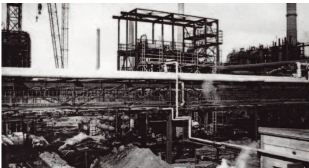
Öldruckvergasungsanlage in Leuna I
