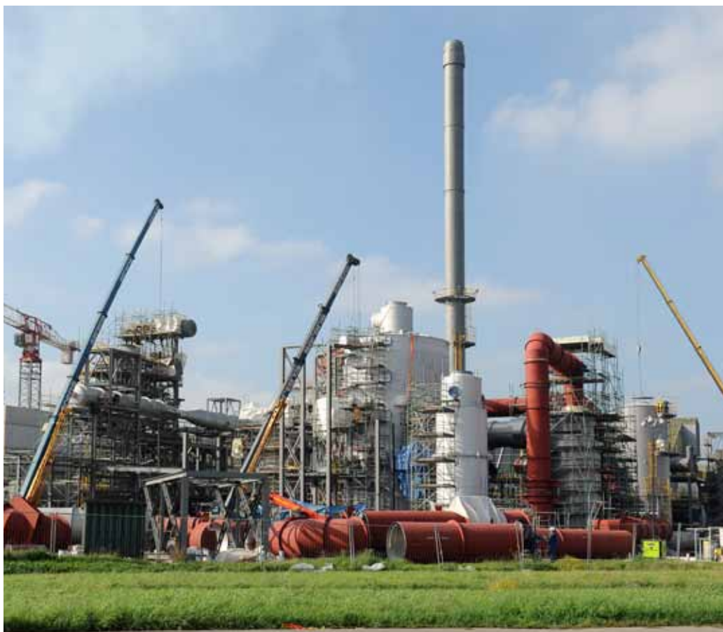
Montage der Schwefelsäureanlage in Antwerpen
