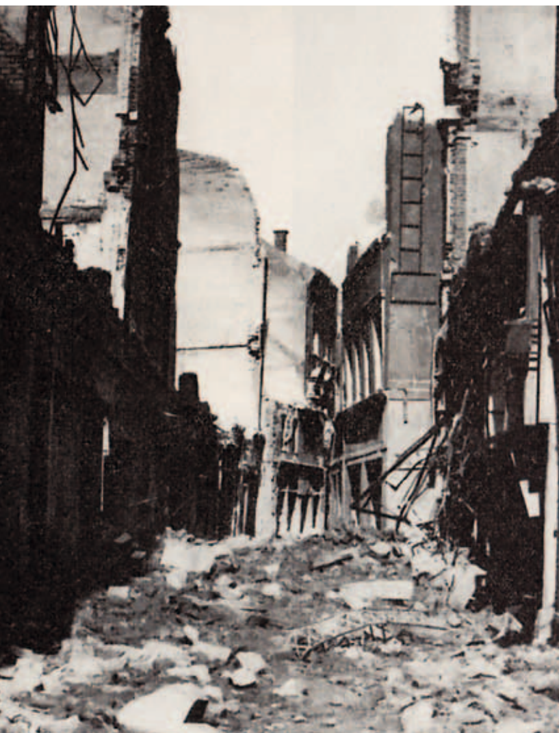
Das Chemnitzer Marktgäßchen nach den Luftangriffen
