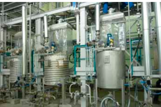
Anlage zur Produktion von Polystyrol in Perm
