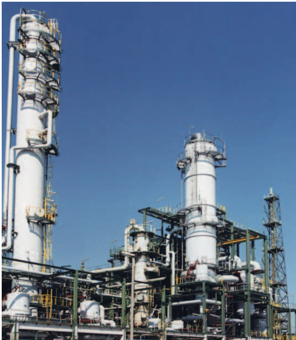
Blick auf die Oxichlorierungsanlage in Buna (Teilansicht)
