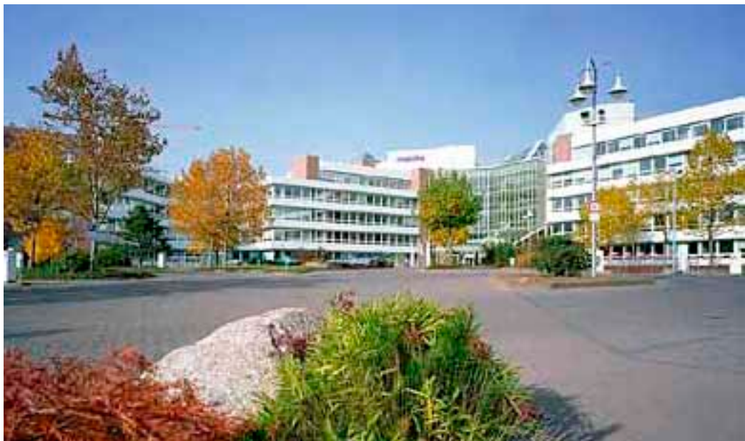
Die Lurgi-Zentrale in Frankfurt/Main
