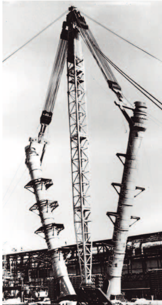
Montage der Reaktoren für die Oxosynthese-Anlage in Perm
