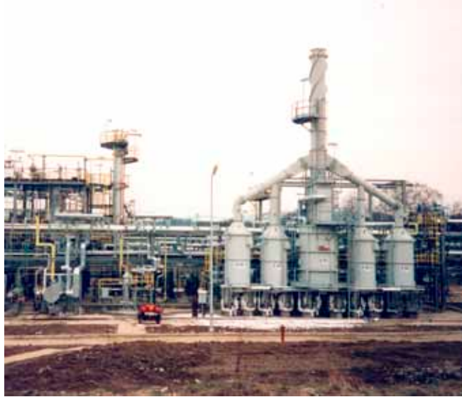
Zeoforminganlage in Gorlice/Polen
