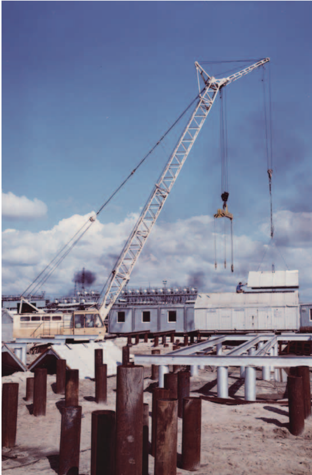
Montage der Boxen für die Erdölaufbereitungsanlagen in Westsibirien
