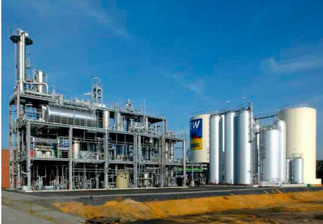
DME-Anlage in Marl
