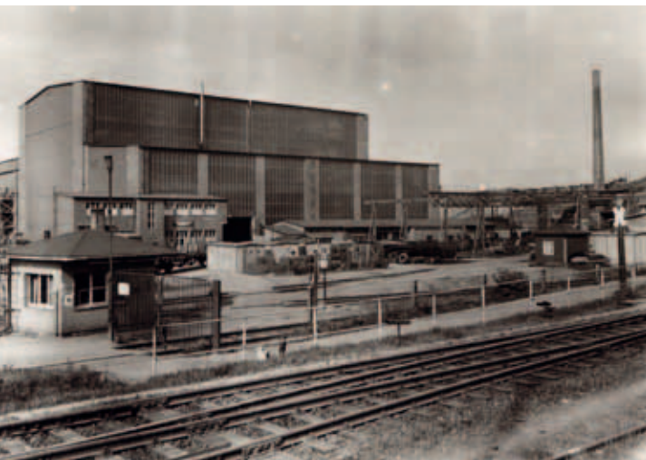
Das hintere Fabriktor auf dem Germania-Gelände
