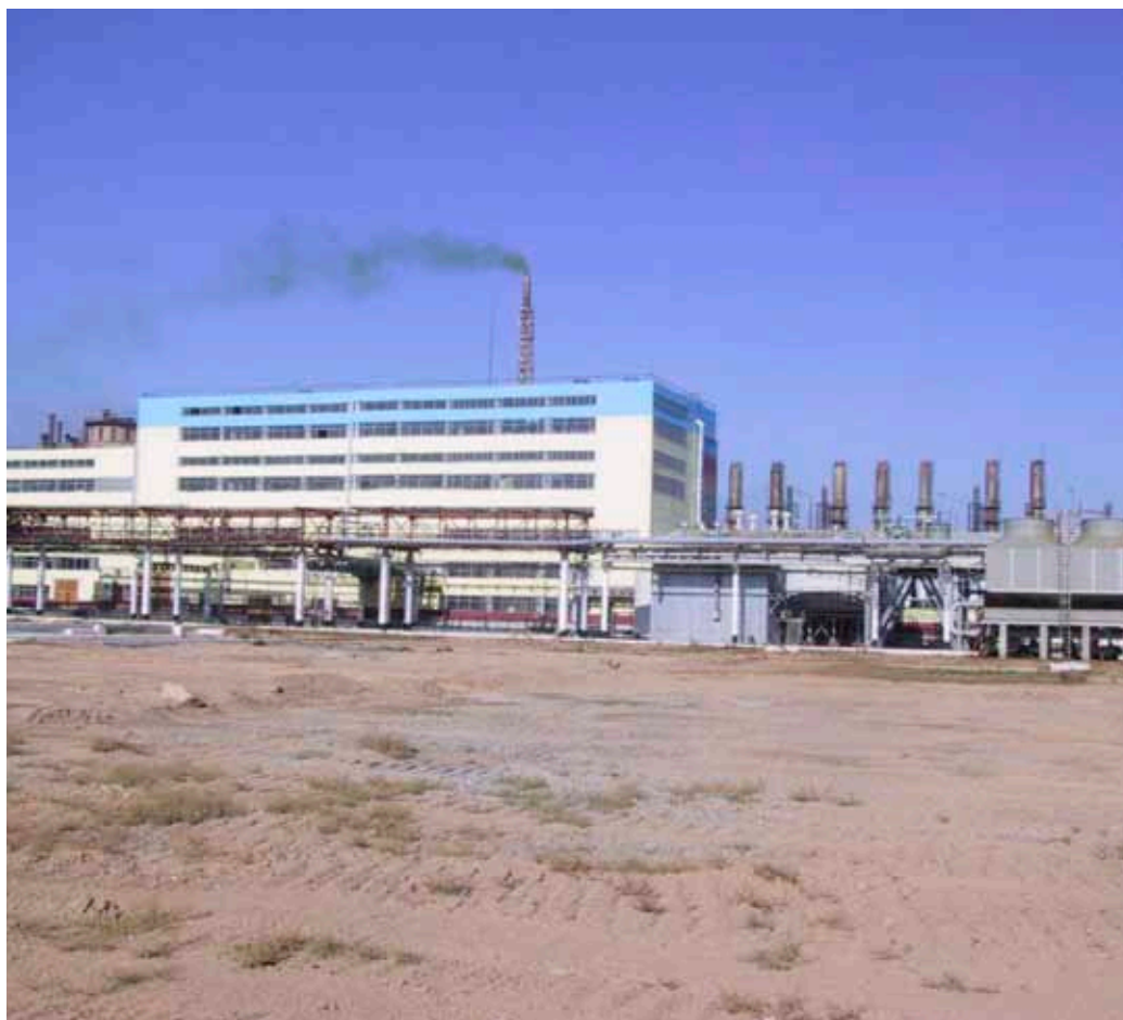
Chlorelektrolyseanlage in Navoi/Usbekistan
