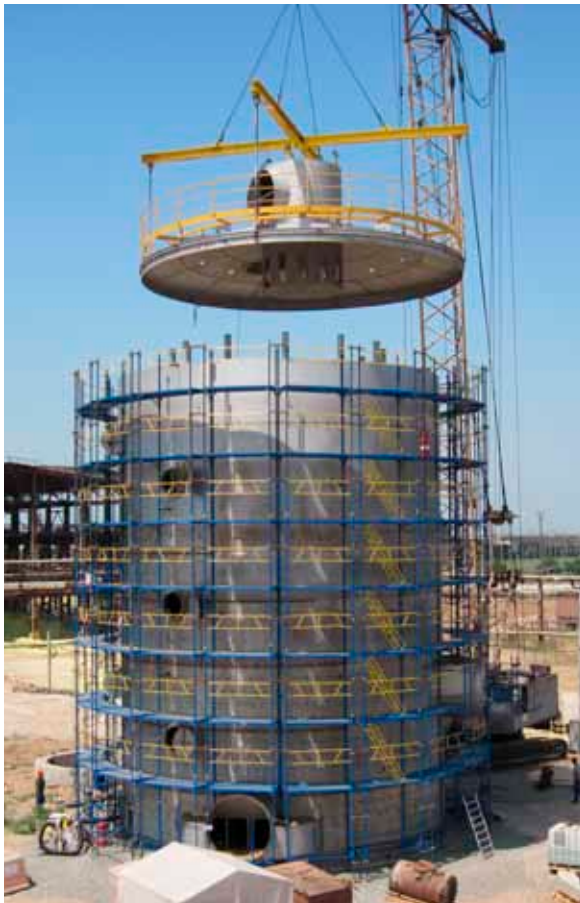
Während der Montagearbeiten der...
