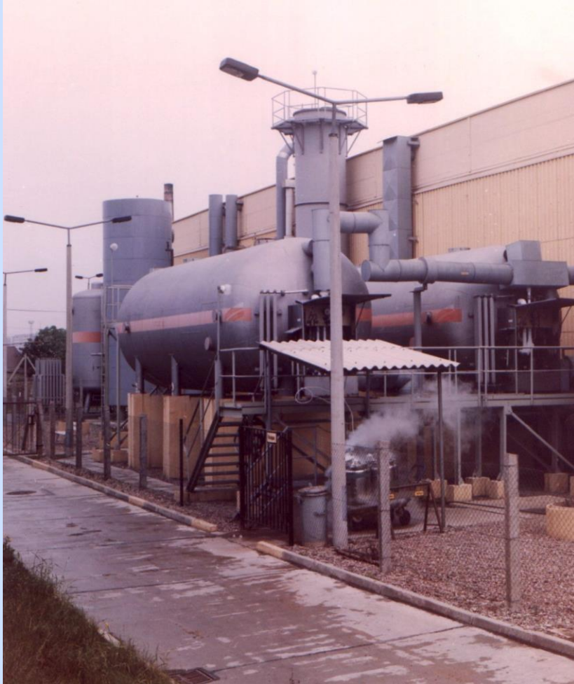
Luftzerlegungsanlage NG 1000 ET LIN-Speichertanks (2x 50 000 l) (Bild 18)
