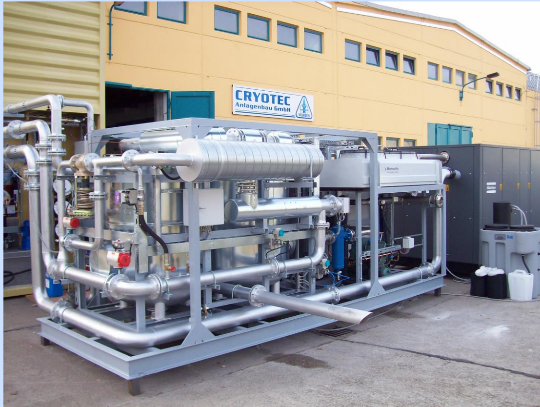
ONL 100 T – Adsorberskid (Bild 40)
