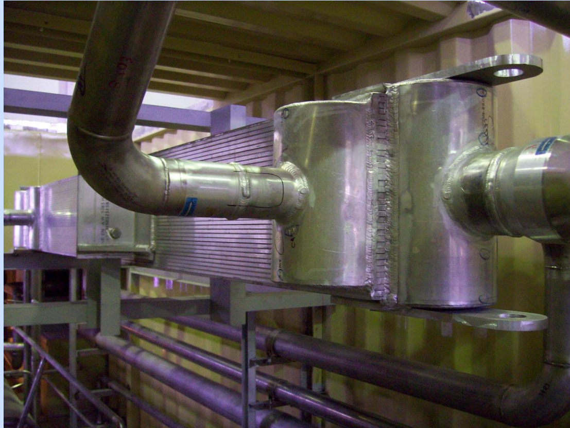
Al-Plattenwärmeübertrager in der Cold Box (Bild 34)
