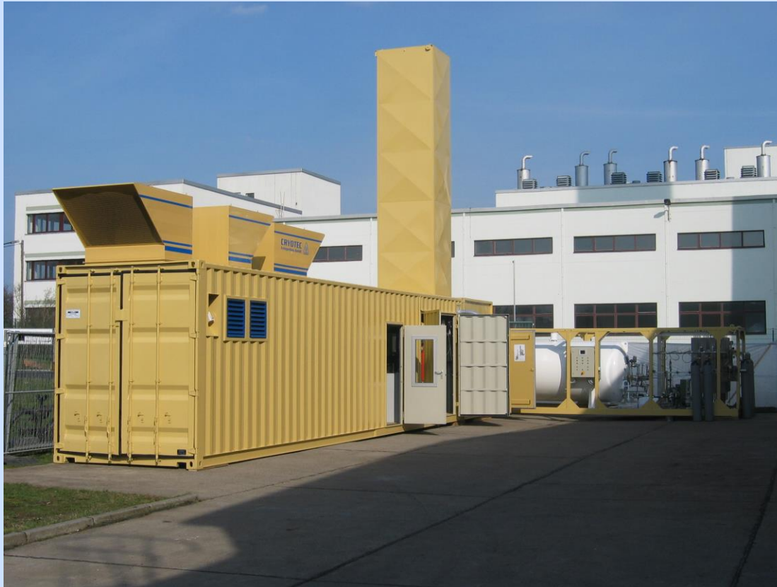
ONL 40 T – Gesamtansicht mit Speichertank und Flaschenabfüllung (Bild 35)
