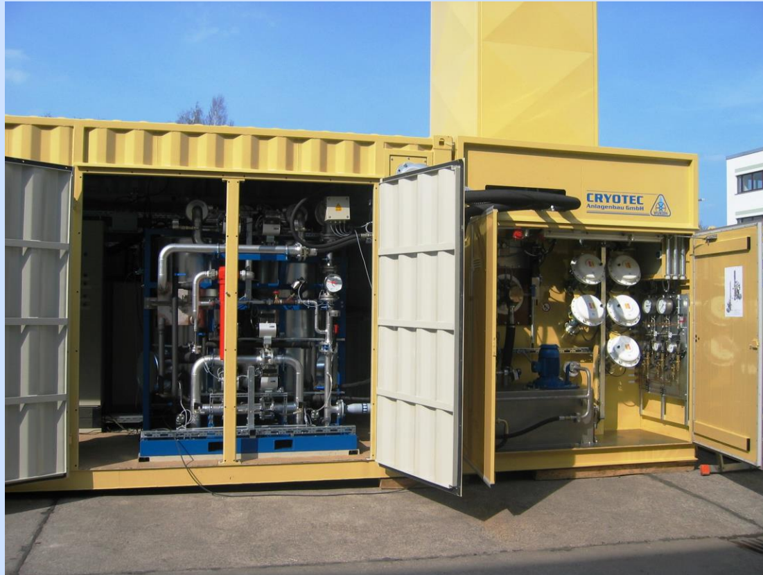
ONL 40 T (Containerbauweise) Molekularsiebbatterie und Schalttafel der Cold Box (Bild 38)
