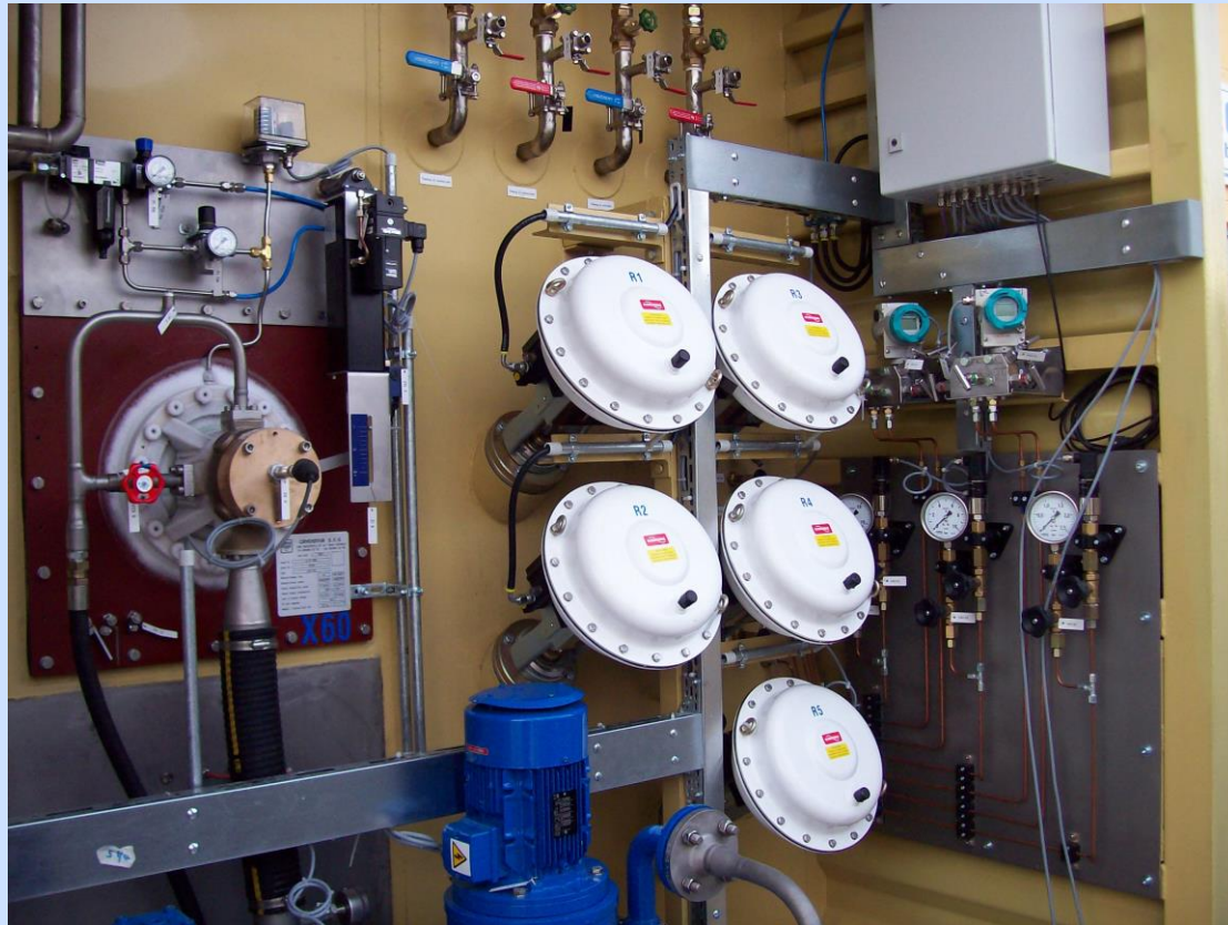
ONL 100 T – Probetrieb Cold Box (Schalttafel) (Bild 43)
