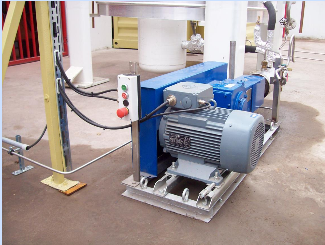
ONL 100 T – Probetrieb Flüssiggaspumpe (Bild 44)
