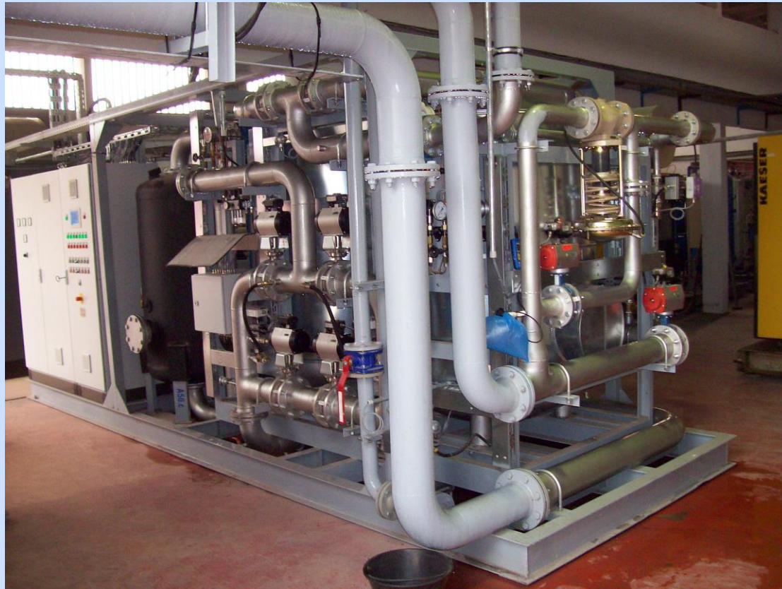
ONL 100 T – Montage in Kamerun (Adsorberskid) (Bild 42)
