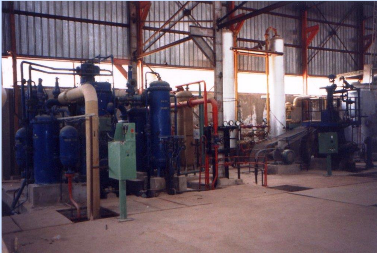
Luftzerlegungsanlage OM 250 (Bild 13)
