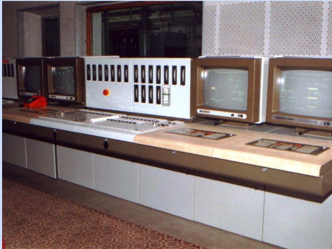
Luftzerlegungsanlage NG 1000 T – Zentraler Überwachungsraum (Vollautomatischer Betrieb mit AUDATEC-Steuerung) (Bild 20)
