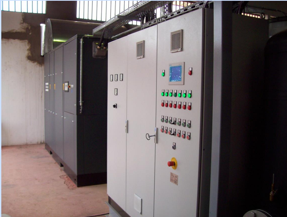
ONL 100 T – Probebetrieb Zentraler Schaltschrank mit SPS (Simatic S7) Steuerung (Bild 46)
