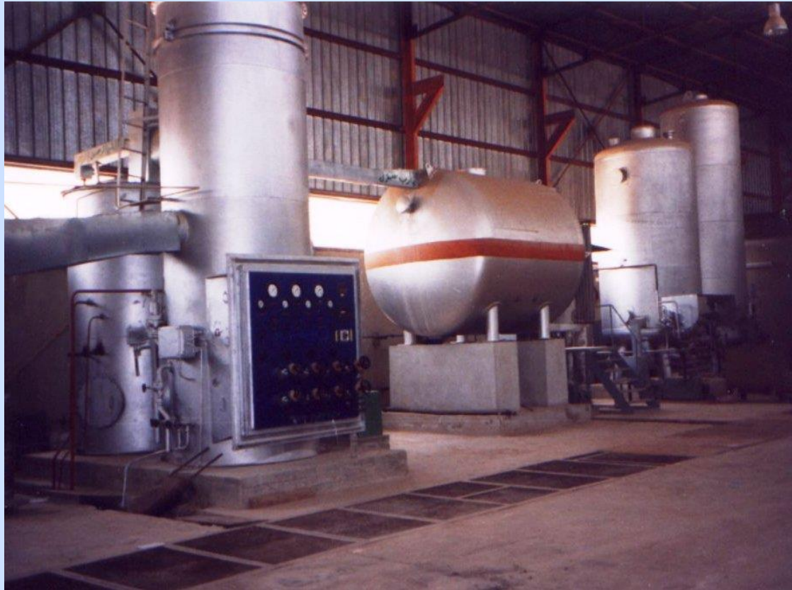
Luftzerlegungsanlage OM 250 (Hallenaufstellung) (Bild 12)
