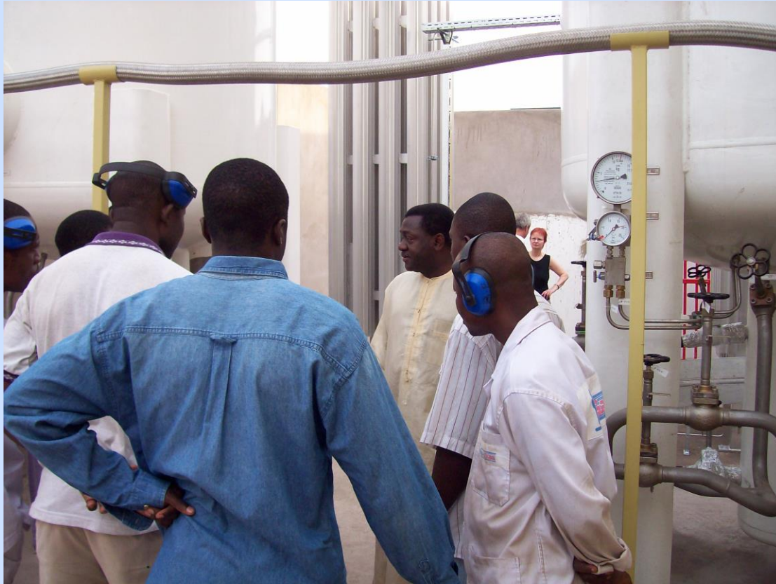
ONL 100 T - Einweisung vor Ort (Bild 49)
