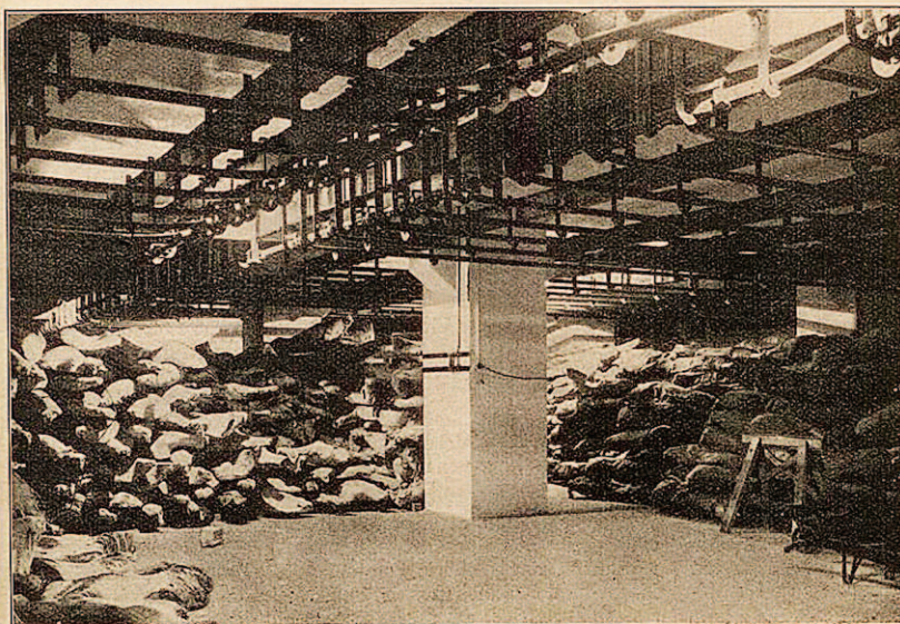
Abb. 8. Gefüllter Kühlraum mit Aufhängevorrichtung im Kühlhaus der »Frigus« in Bremerhaven.
