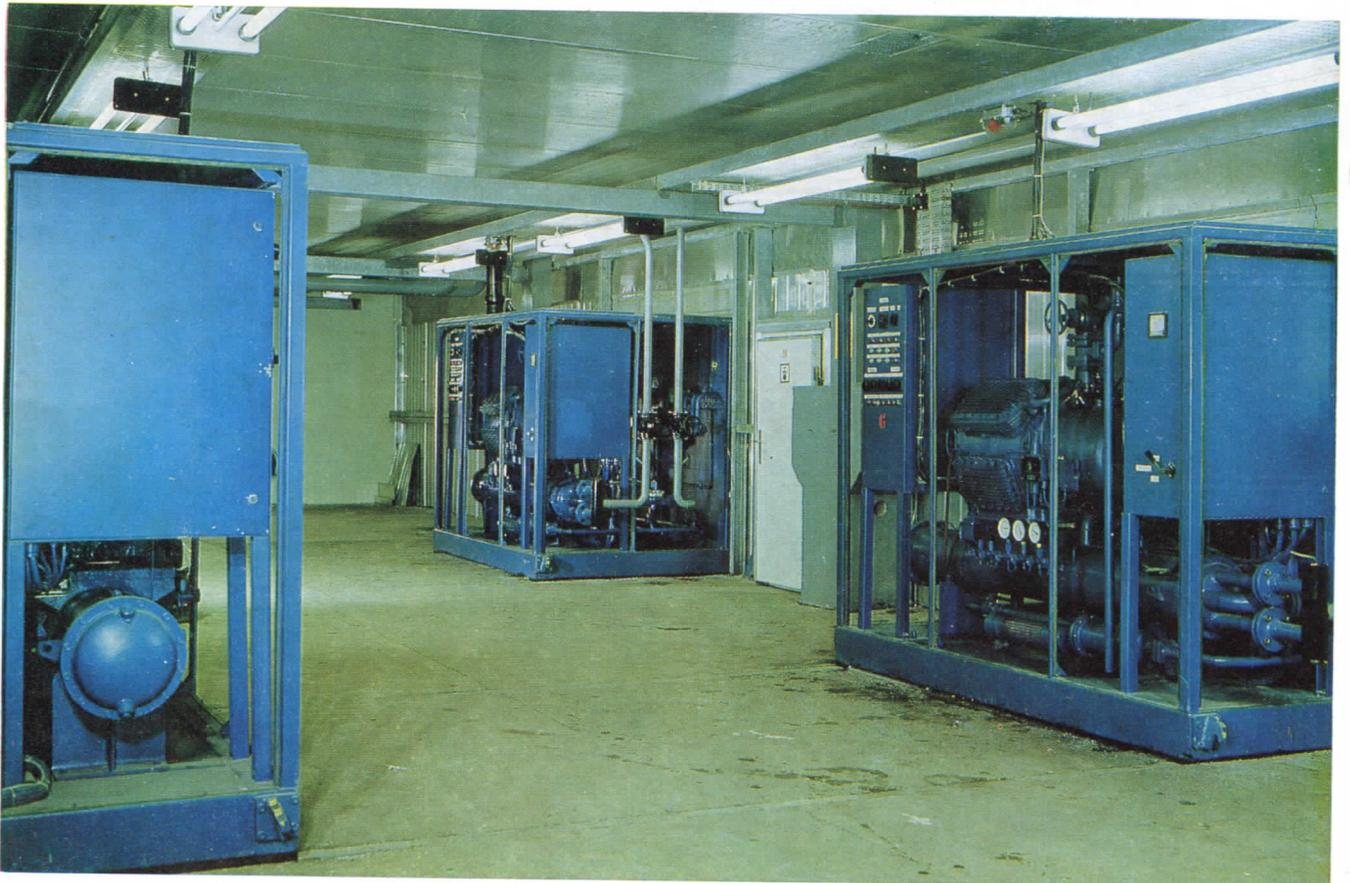
Wir nutzen werksmontierte Kältesätze vom Typ KWS kombiniert zur Kaltwasserkühlung, zur Versorgung der Luftkühler der Klimablöcke und zur Warmwasserbereitstellung aus den Kondensatoren dieser KWS. Die Verbindung mit einer Brunnenanlage dient zum Energieausgleich der Klimablöcke, die ebenfalls zur Luftheizung genutzt werden. Die Heizleistung beträgt ca. 270 kW. Das Verfahrensschema zeigt die ILKA-Lösung.
