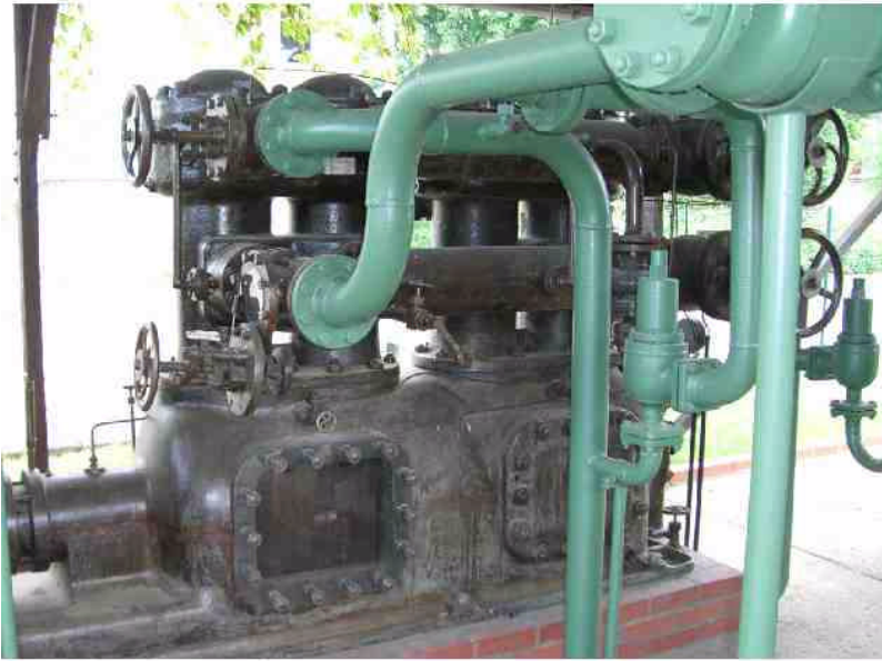
Borsig-NH 3 -Kälteanlage von 1924 im Chemiemuseum Merseburg.
