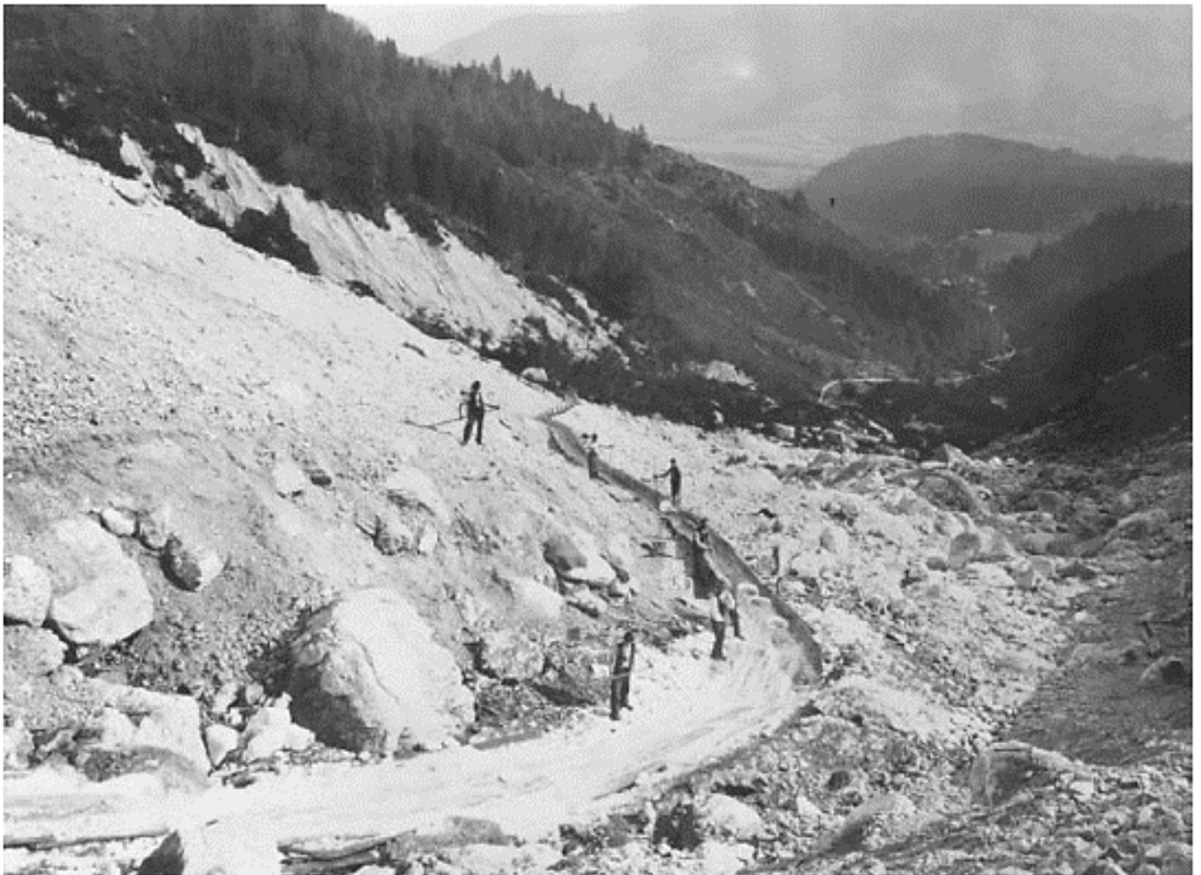
Blick auf die Eisrutsche zum Örgenkessel. Auf der Strecke sorgten Posten für „freie Bahn“ und den Weitertransport.
