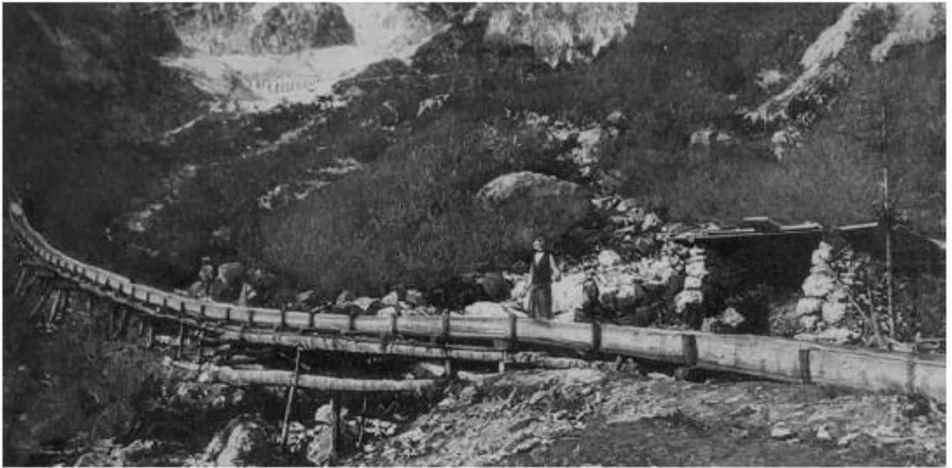
Auf einer 1600 m langen Holzrutsche wurden die Eisblöcke ins Ullachtal bis zum Örgenkessel befördert
