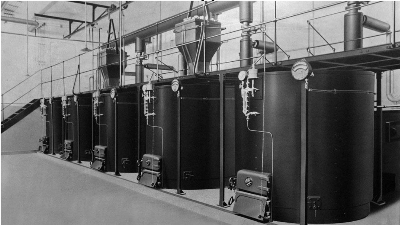
Heiz- und Kühlanlagen im Wiener Versorgungsheim. Fünf Ringglieder-Kessel á 40 m 2 Heizfläche im Kesselhaus des Pavillon 8. Sie wurden von der Firma Kurz A.-G. in Wien 13. Bez. (heute 14. Bez.) gefertigt. Die Beschickung mit Koks erfolgte durch die Laufkatzen oben.
