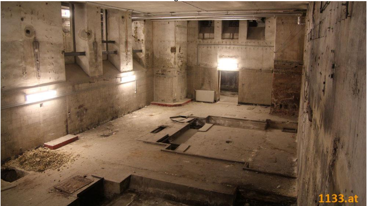
Heiz- und Kühlanlagen im Wiener Versorgungsheim. Das zwei Stock hohe unterirdische Heizhaus
