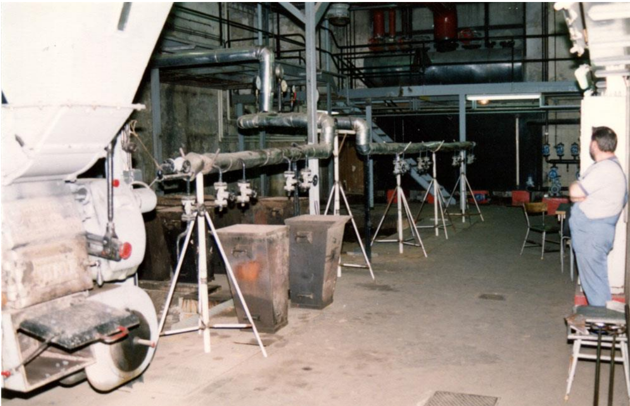
Heiz- und Kühlanlagen im Wiener Versorgungsheim. Blick in das Kesselhaus des Pavillon 1. Die vier Öl-Kessel waren bereits abmontiert, links steht noch der Koks-Kessel. Fotografiert am 10. Jänner 1991 © Archiv Gerzabek
