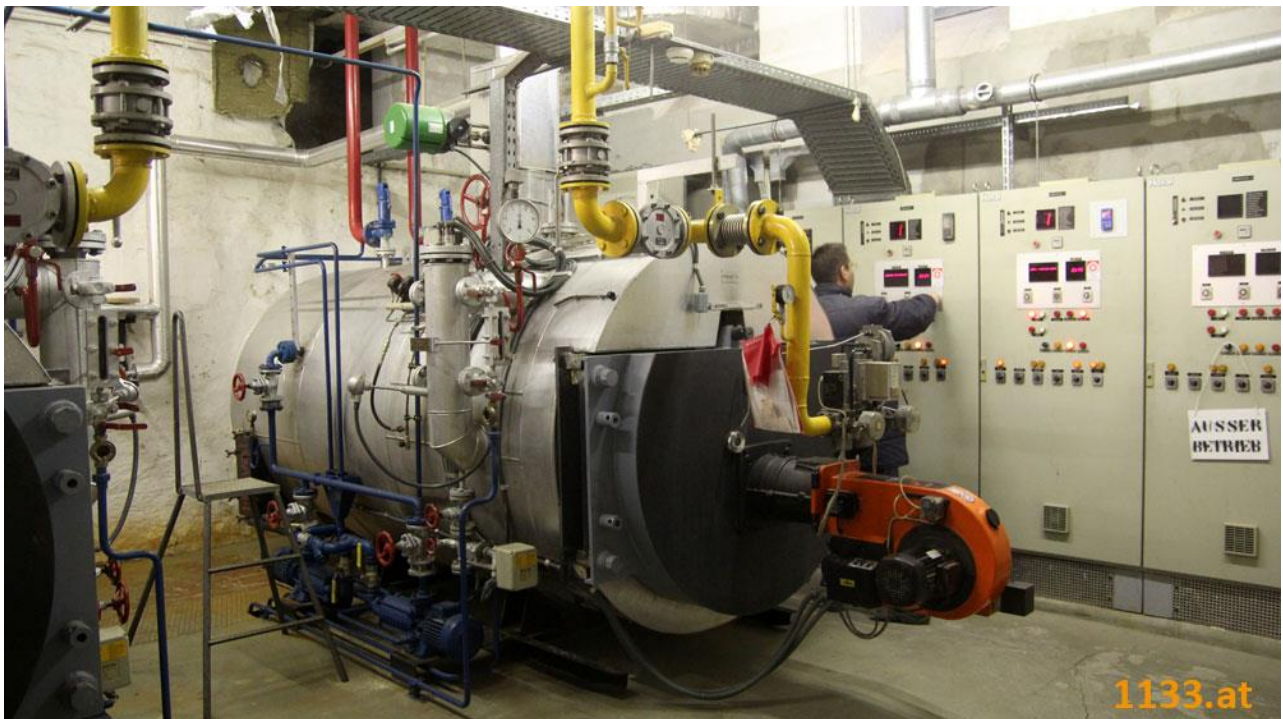
Heiz- und Kühlanlagen im Wiener Versorgungsheim. Die neuen Gaskesselanlagen, die 2000 zur Versorgung der Küche installiert wurden. Fotografiert am 17. Februar 2012 © Archiv 1133.at
