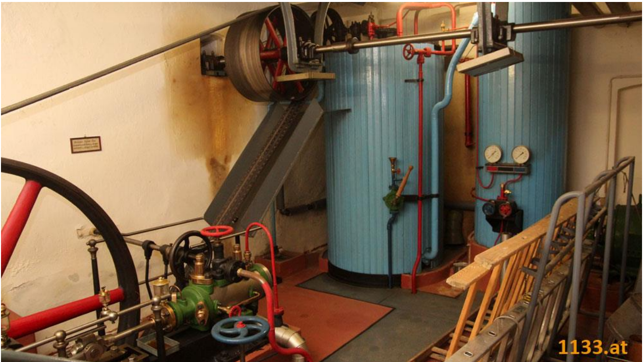
Heiz- und Kühlanlagen im Wiener Versorgungsheim. Der Raum mit der Kompressor-Kühlmaschine, die 1997 außer Betrieb genommen wurde. Fotografiert am 17. Februar 2012 © Archiv 1133.at
