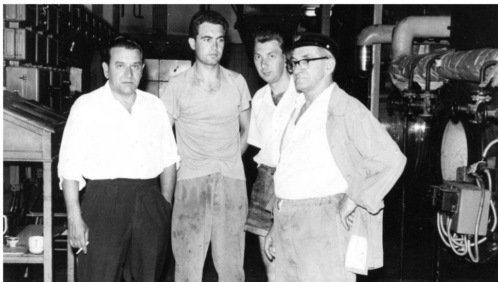
Heiz- und Kühlanlagen im Wiener Versorgungsheim. Die Heizer im Kesselhaus des Pavillon 1, fotografiert im Juni 1965. Von links nach rechts: Pfeil, Gerzabek, Schneider, Konrad © Archiv Gerzabek
