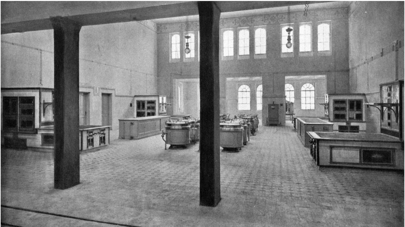
Der große Küchenraum des Wiener Versorgungsheimes. Foto aus der Gedenkschrift zur Eröffnung 1904 © Archiv 1133.at
