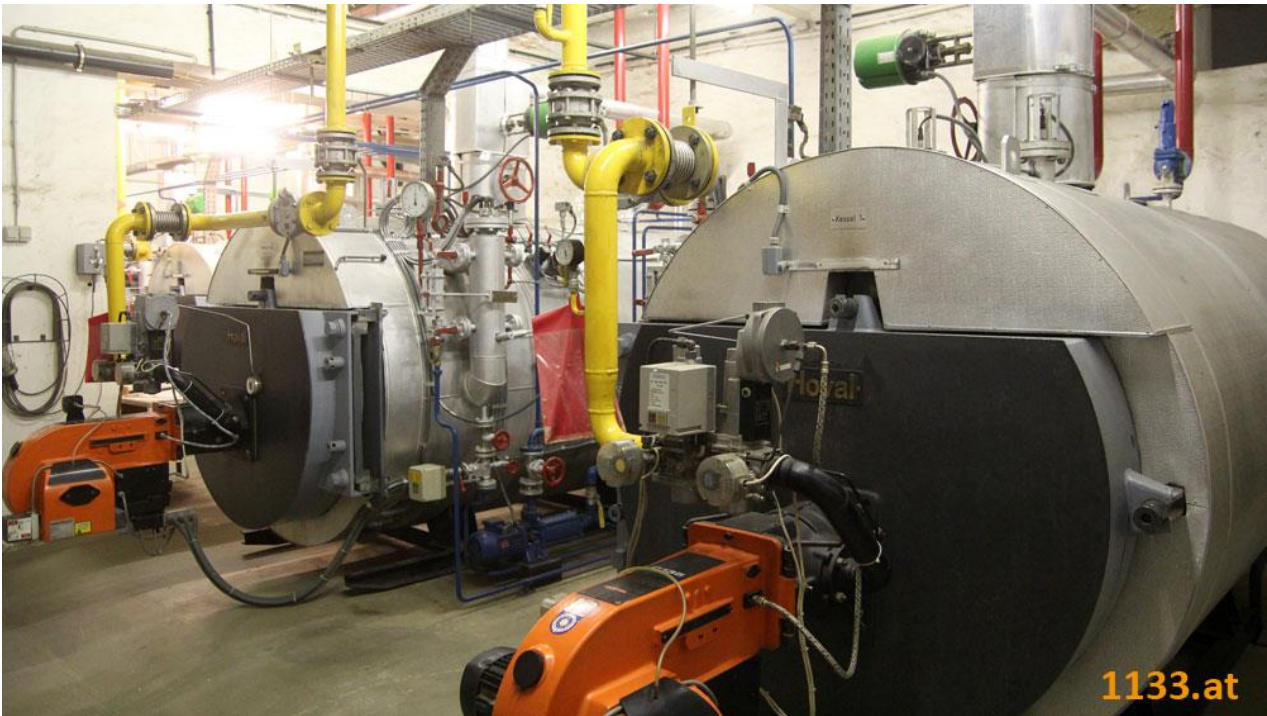
Heiz- und Kühlanlagen im Wiener Versorgungsheim. Die neuen Gaskesselanlagen, die 2000 zur Versorgung des Küchengebäudes installiert wurden. Fotografiert am 17. Februar 2012 © Archiv 1133.at
