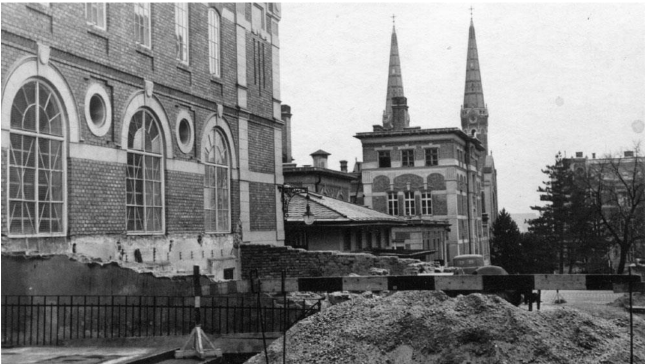
Heiz- und Kühlanlagen im Wiener Versorgungsheim. Im ehemaligen Wäschereigebäude links im Bild ist jetzt der Festaal untergebracht. Im Kellergeschoß war früher die Wärme- und Kraftzentrale der Wäscherei untergebracht, die Kompressor-Kühlmaschine arbeitete bis 1997. Dieses Foto aus dem Dezember 1963 zeigt den Abbruch des alten Kesselraumes. An seiner Stelle wurde ein Anbau für die neue Heizwerkstätte errichtet. Weiter hinten sind das Küchengebäude und dahinter die Türme der Versorgungsheimkirche zu sehen. © Archiv Gerzabek
