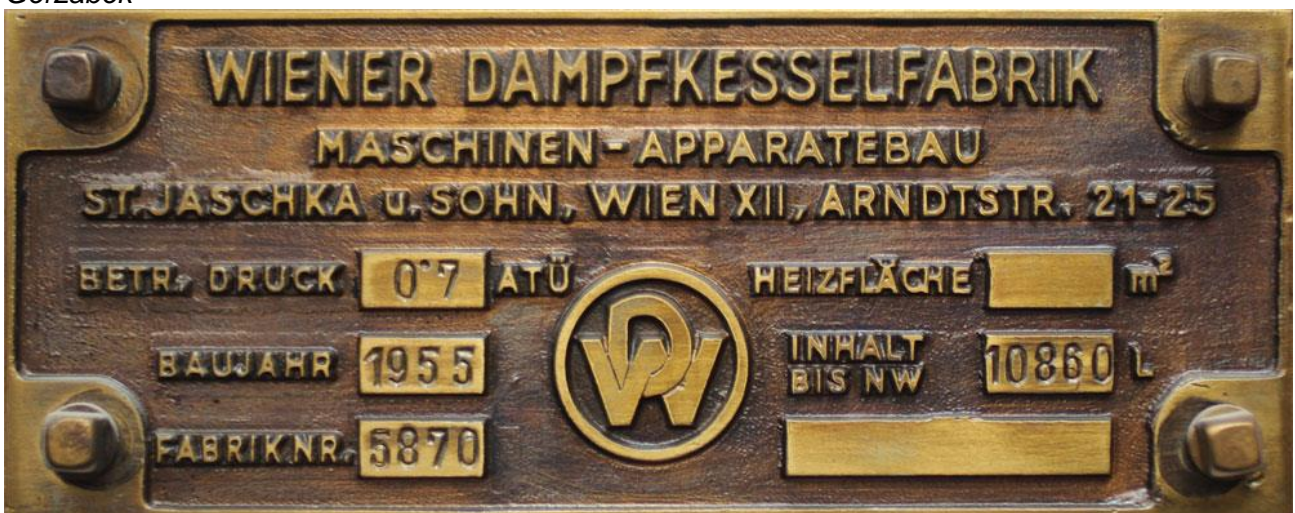
Heiz- und Kühlanlagen im Wiener Versorgungsheim. Das Typenschild eines der Ölkessel im Pavillon I © Archiv 1133.at
