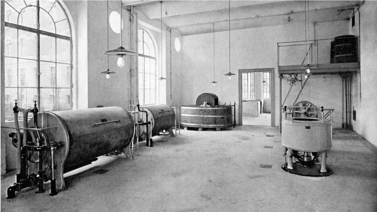
Der Waschraum im Wäschereigebäude des Wiener Versorgungsheimes. Die Dampfwäscherei wurden nach Entwürfen des Ingenieurs Max Temme von diesem und dem Maschinenfabrikanten A. Kroi geliefert. Die Versorgung der Maschinen mit Dampf, heißem und kaltem Wasser und der Riemenantrieb erfolgt von unten aus dem Maschinenhaus. Foto aus der Gedenkschrift zur Eröffnung 1904 © Archiv 1133.at
