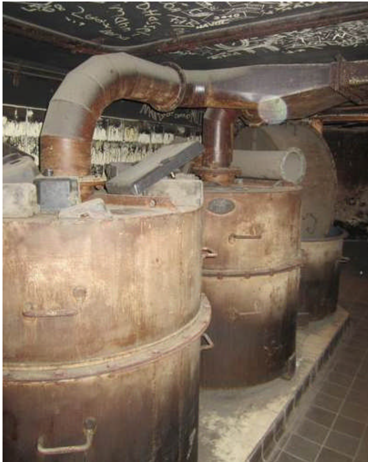
Bild 11: Aktivkohlefilter in der Außenluftleitung zum Ventilator
