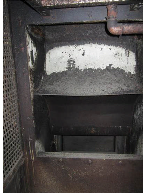
Bild 10: Blick auf den Umlufteintritt vom oberen und unteren Geschoss ins Gerät. Das Rohr oben rechts ist der Rücklauf des Zulufterhitzers, dessen Unterkante zu erkennen ist.
