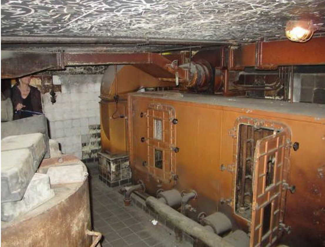
Bild 5: Blick in den Technikraum. Rechts der Kühlwäscher, Fabrikat Wiessner, links Aktivkohlefilter. Oben: Außenluftkanal zwischen Aktivkohlefilter und Klimagerät.
