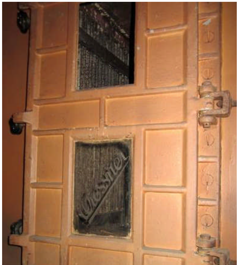
Bild 9: Eine Tür des Kühlwäschers Man erkennt innen die Tropfenabscheider.
