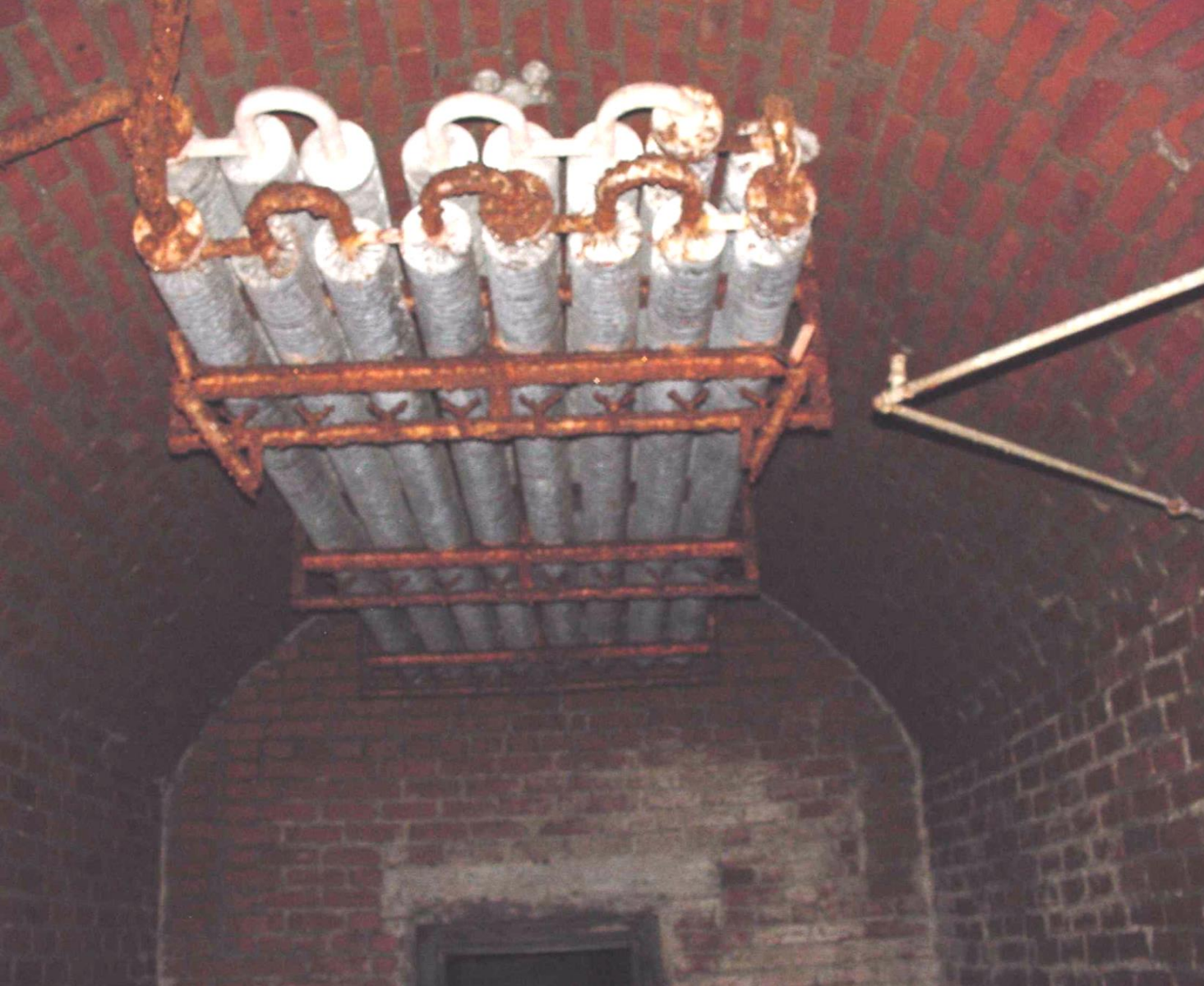
einer der 2 Deckenverdampfer
