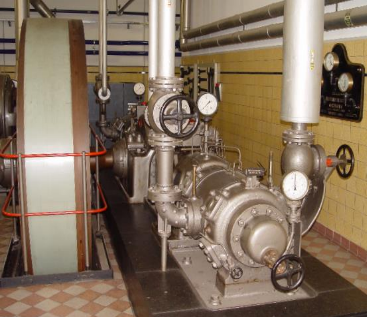
Verdichter System Linde, Hersteller Maschinenfabrik Esslingen, Type 2/40L400, Baujahr 1939
