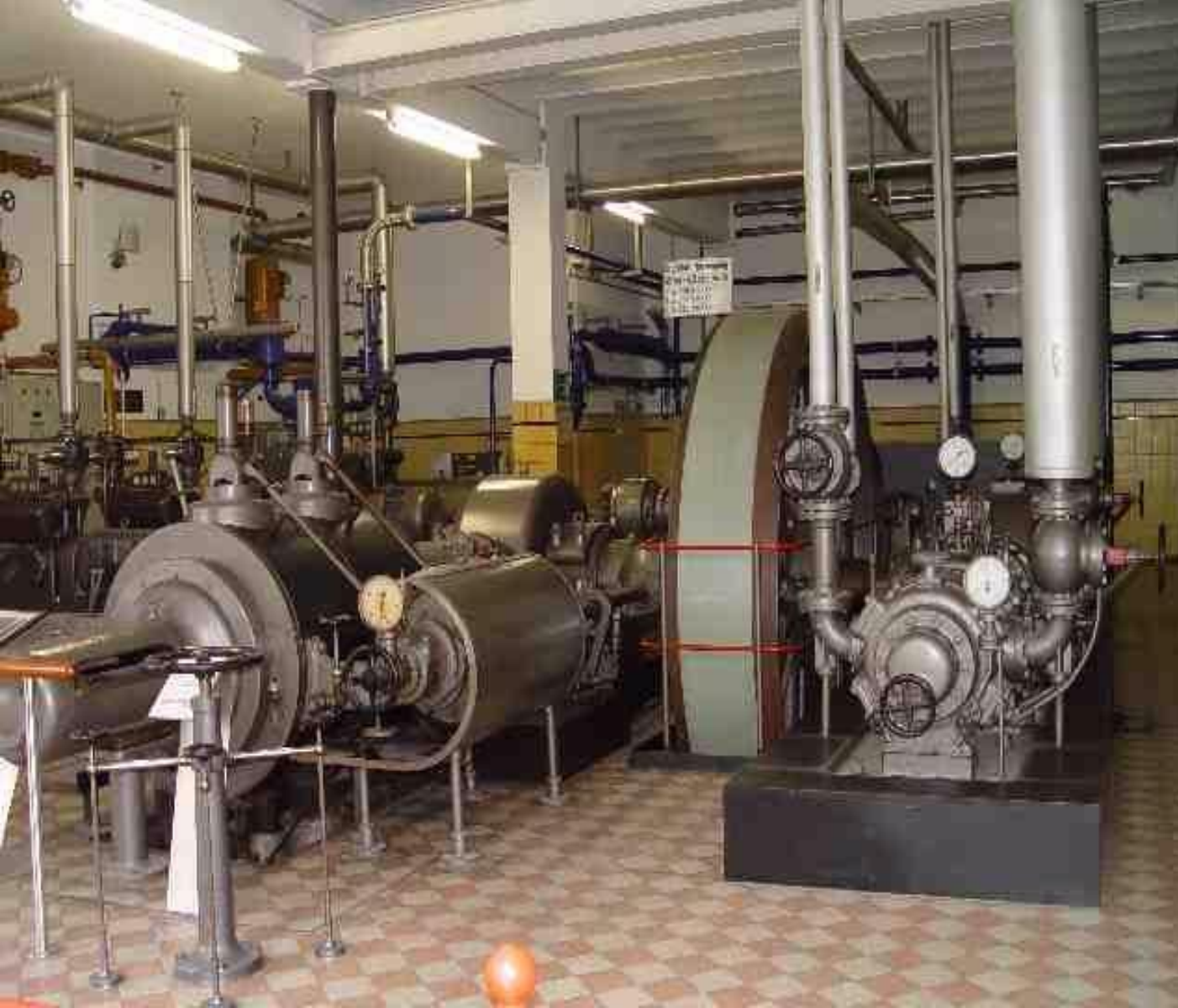
Kälteanlage mit Dampfmaschinen- antrieb und Generator
