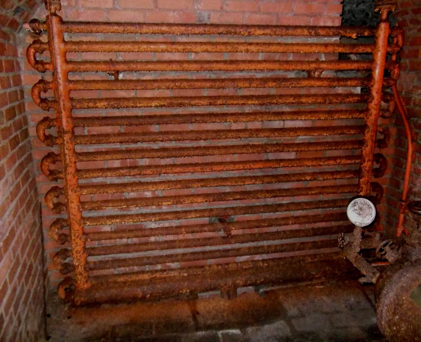
Wassergekühlter Doppelrohr- Kondensator
