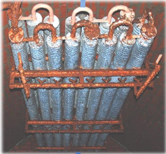
Deckenverdampfer, in dem das Kältemittel unter Wärmeaufnahme aus der Raumluft verdampft
