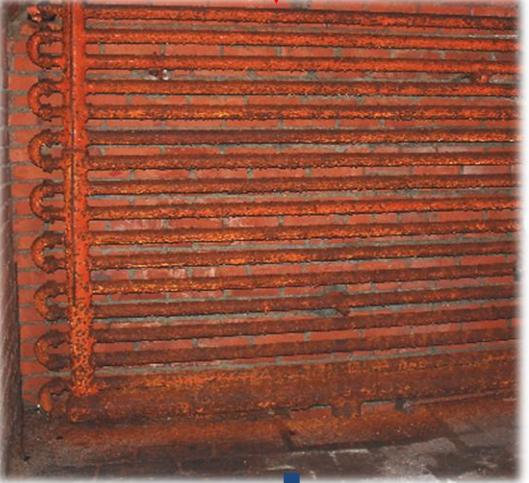
wassergekühlter Rohr-Verflüssiger, in dem das verdichtete Kältemittel unter Wärmeabgabe verflüssigt wird
