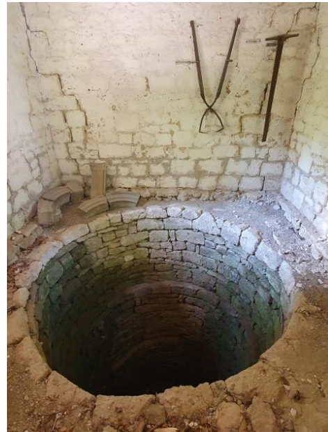
Bilder Gerhard Gregor: Das Gebäude des Eiskellers und der eigentliche Eiskeller mit einem Durchmesser von 2,90 m und einer Tiefe von über 4,50 m mit Werkzeugen zur Eisgewinnung
