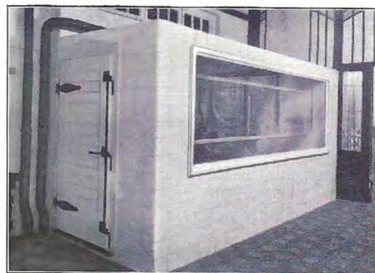
Fig. Nr. 14 Fleischkühlschrank mit Solekühlung in einem Warenhaus
