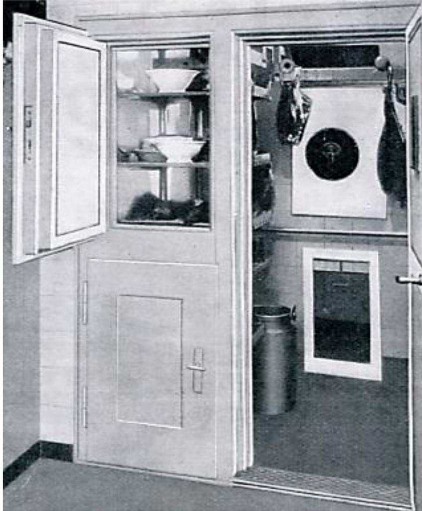
Abb. 16. Größerer Hotelkühlschrank für Solekühlung, angeschlossen an einen größeren Kühlautomaten.
