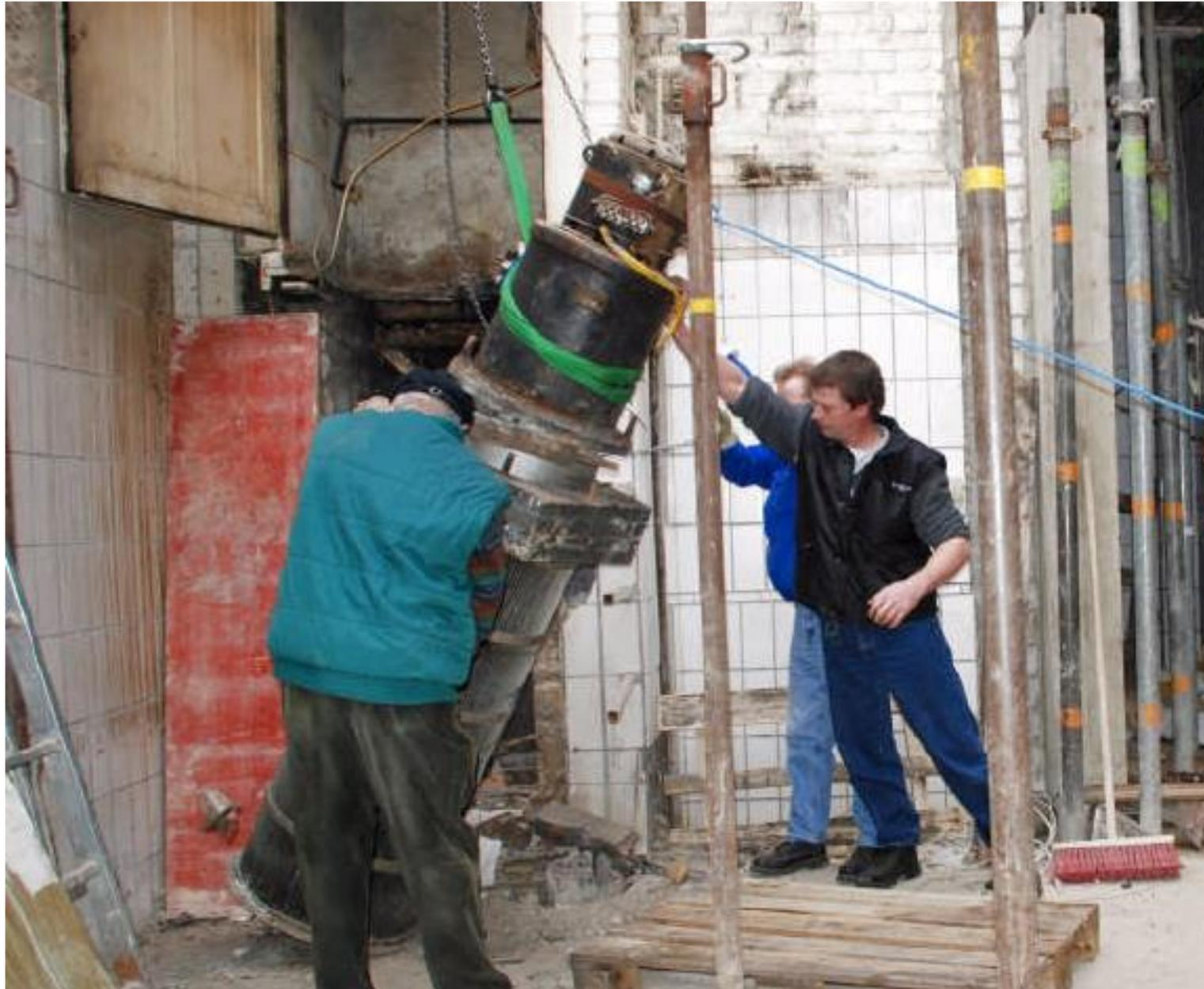
Der HKK hatte 2016 einen Autofrigor Typ VI beim Umbau einer Metzgerei in Frankfurt geborgen. Größe 2,5 m, Gewicht 1,5 t Kälteleistung 7250 kcal/h bei  $-7^{\circ}\text{C}$  VT
