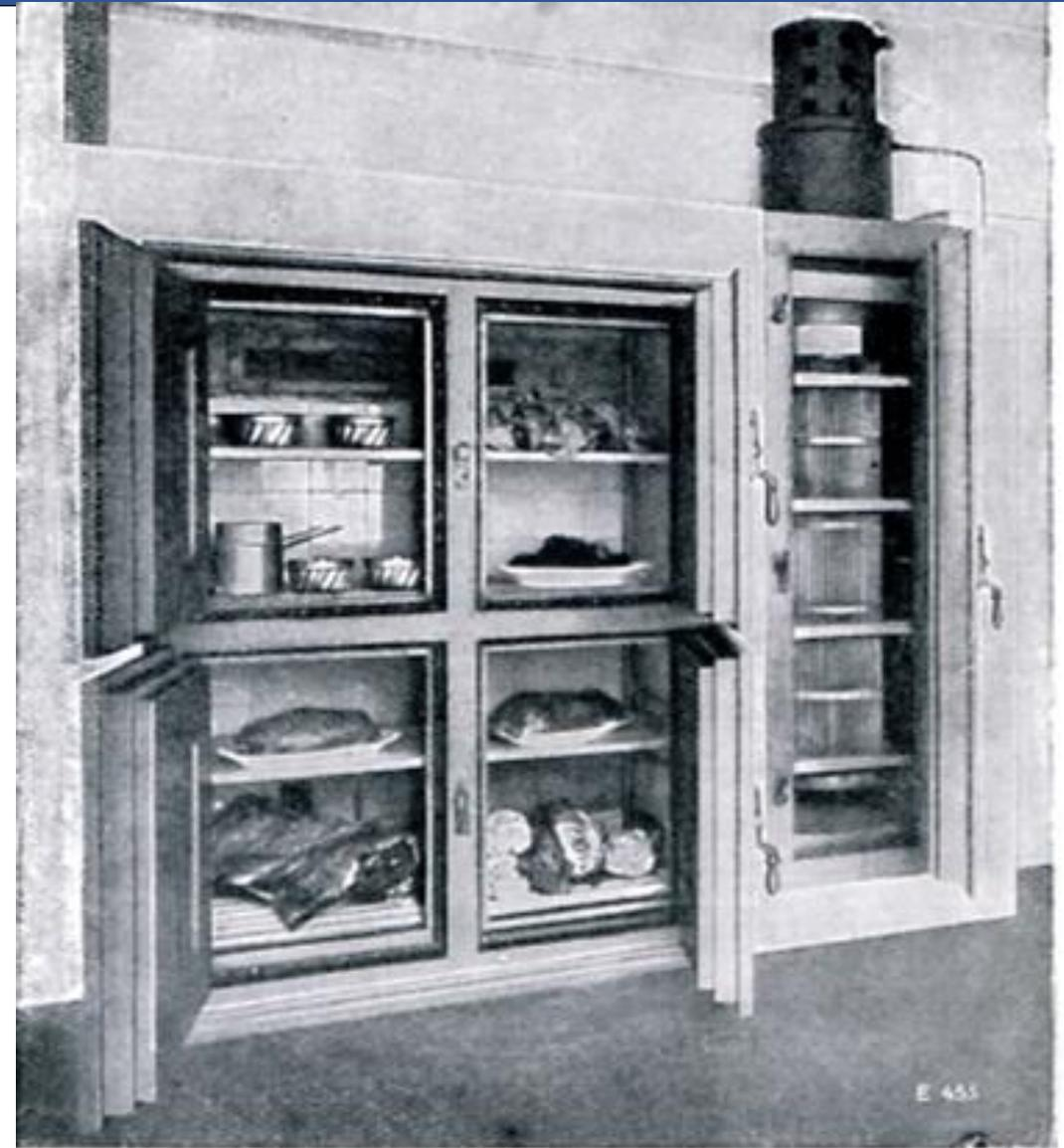
Abb. 17. Gemauerter Hotelkühlschrank f. Luftkühlung m. Maschine A2002.
